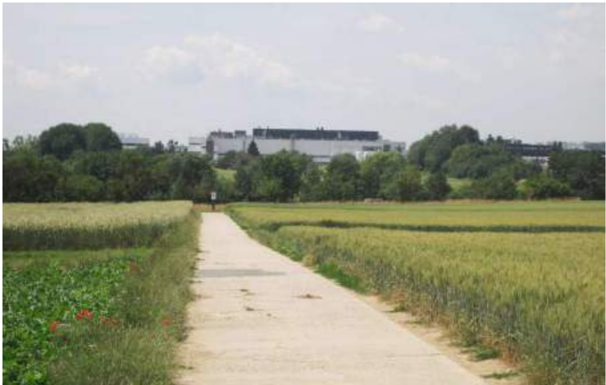
Foto: Visuelle Fernwirkung von Gewerbebebauung in der freien Feldflur am Beispiel Kronberg Süd
