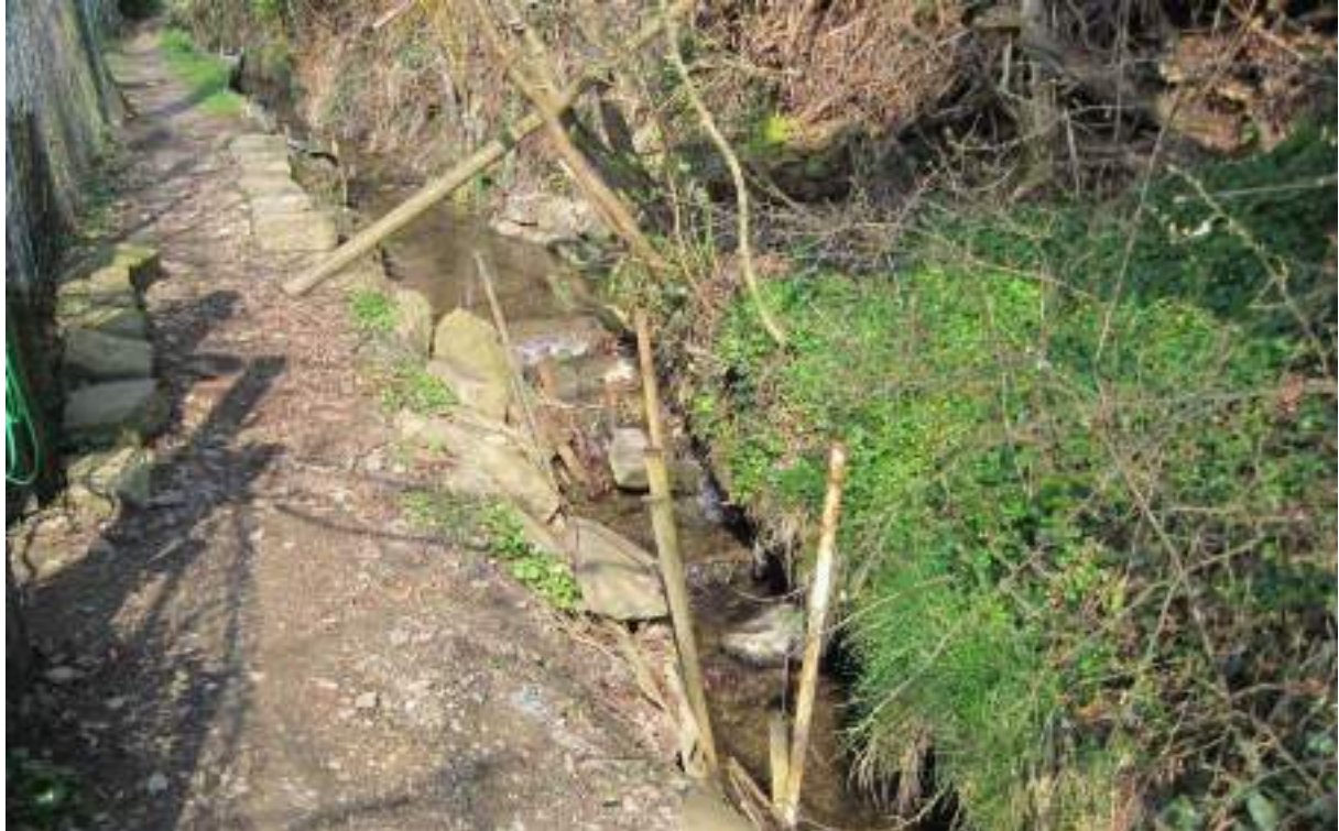
Foto: Eingegengter Rentbach mit improvisierter Uferbefestigung
